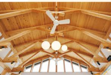
宮村さんが設計された、びわ湖材100%の屋根架構。木材を折れ線状につなげたアーチが特徴。(琵琶湖汽船 今津営業所)
